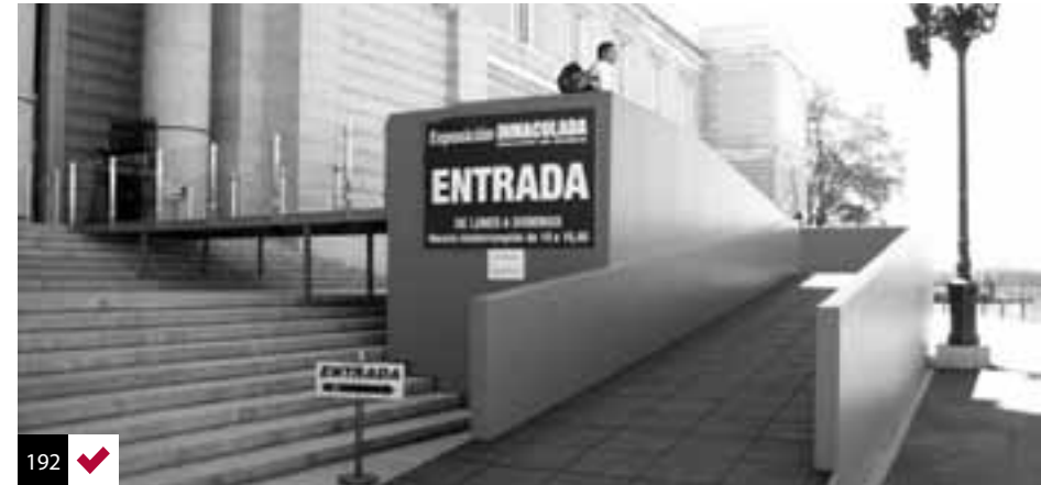
Foto 192: rampa mecano removible en el acceso a la catedral de Santa María la Real de la Almuneda. Madrid, España.
