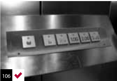
Foto 106: botonera horizontal de fácil alcance y detección.
