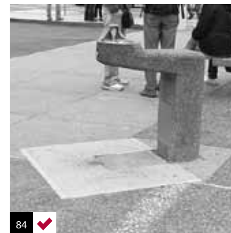
Foto 84: textura de advertencia en el piso informa a personas ciegas de un riesgo en el recorrido. San Francisco, EE.UU.
