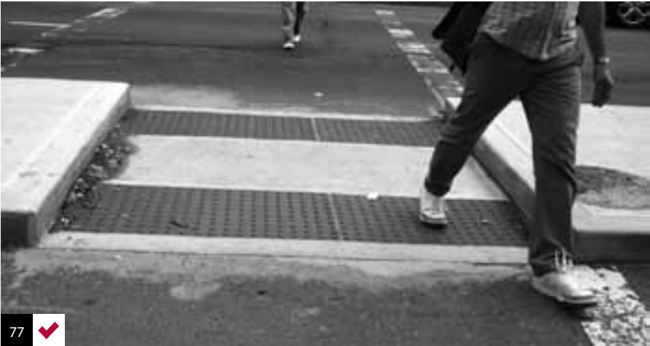
Foto 77: cruces intermedios de diseño universal. Una franja de guía táctil de alerta advierte del cruce, se rebaja en todo su ancho y mantiene la cota de la calzada. Nueva York, EE.UU.
