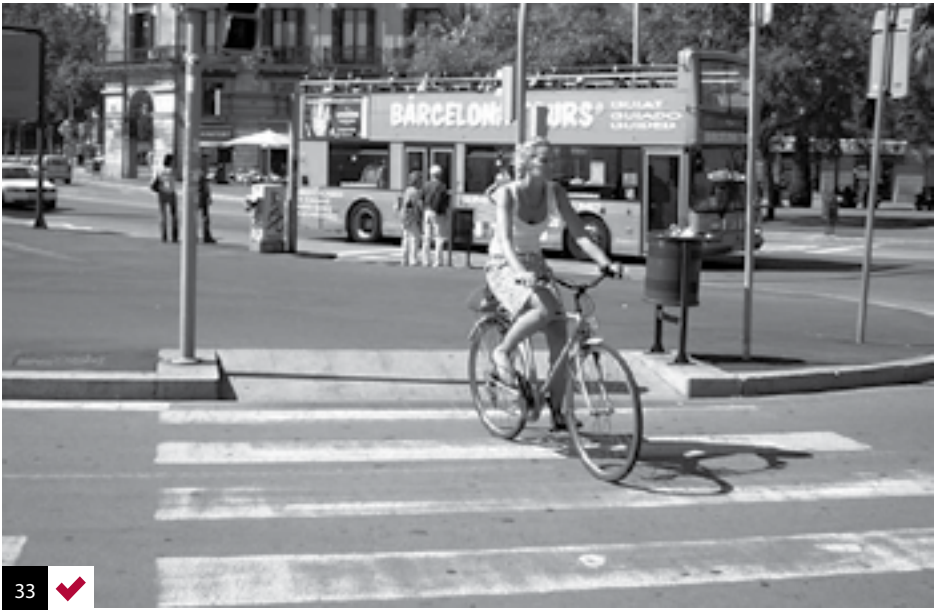
Foto 33: rebaje de vereda en todo el ancho del cruce peatonal, de buena pendiente y protecciones laterales. Barcelona, España.
