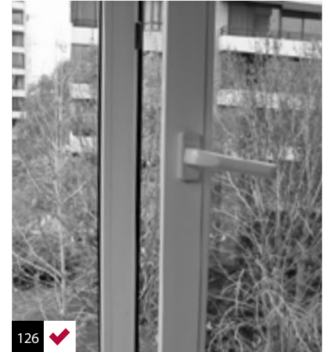
Foto 126: cerrajería que permite un buen apoyo de mano para efectuar las maniobras de apertura o cierre.
