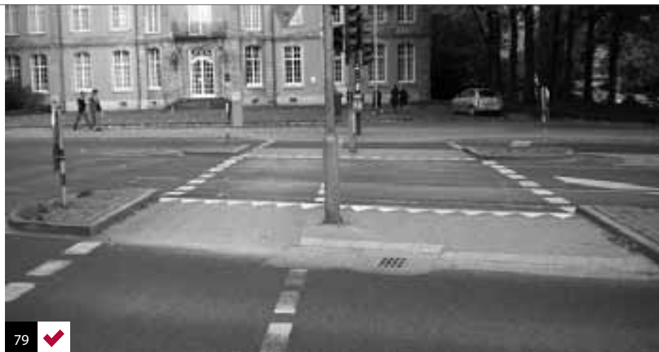
Foto 79: cruces intermedios de diseño universal. Mantiene la cota de la calzada y el ancho completo ofrece oportunidad de cruce a todas las personas. Düsseldorf, Alemania.
