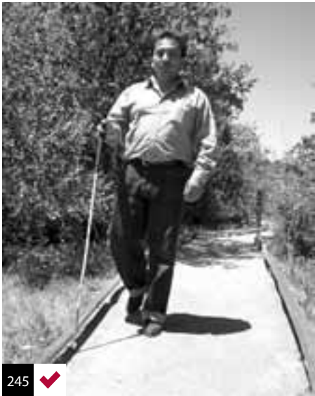
Foto 245: barra guía a nivel del suelo en circuito. Sendero Las Orquídeas – Conaf, Chile.
