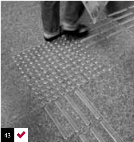
Foto 43: buena implementación de pavimento táctil. Tokio, Japón.
