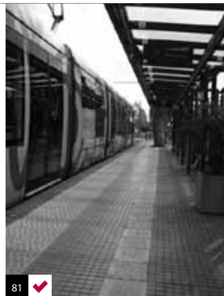
Foto 81: correcta utilización de guías táctiles en zona de transbordo. Buenos Aires, Argentina.
