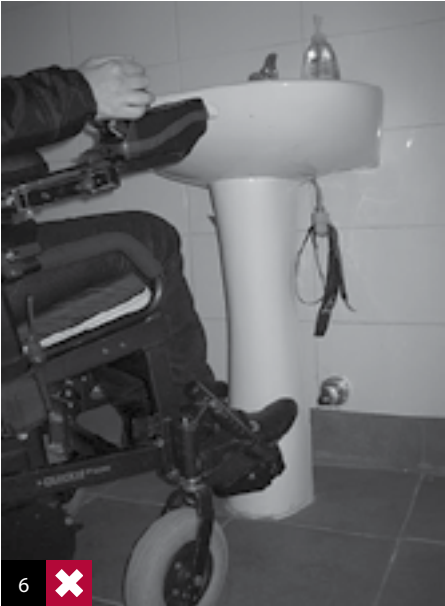
Foto 6: un lavamanos con pedestal no es accesible a una silla de ruedas. El pedestal impide el acercamiento de los apoya pies.
