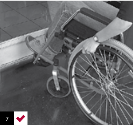
Foto 7: las puertas vidriadas requieren una protección a la altura de los apoya pies para evitar golpes en el vidrio.
