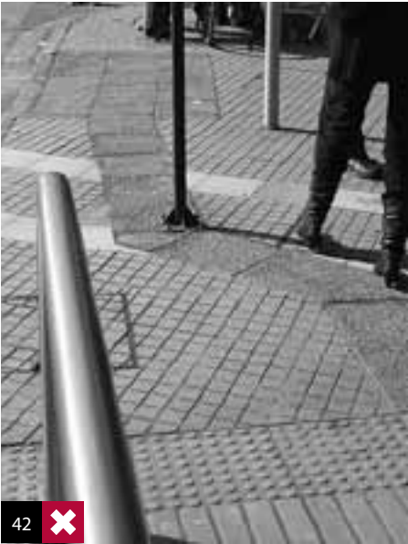
Foto 42: mal uso y exceso de texturas. Señalización vertical en medio de lo que se pretende sea la franja de circulación segura. Paradero Transantiago. Santiago, Chile.
