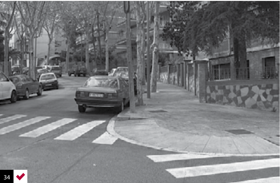
Foto 34: rebaje en esquina de pendiente adecuada. Se produce un descenso completo de ésta, coincidiendo con el paso cebra de circulación peatonal. La textura del rebaje advierte del cruce. Barcelona, España.
