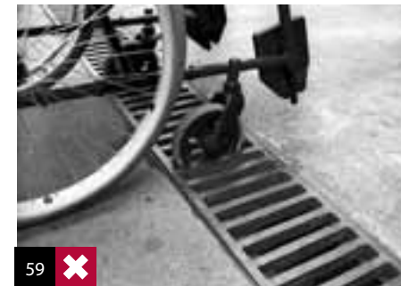
Foto 59: si la separación de la rejilla y su orientación es inadecuada, provoca la situación descrita en la foto con ruedas de sillas o coches de niños.
